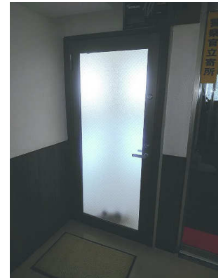
事務所出入口
